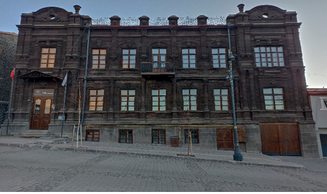
Görsel 9: Sağlık Müdürlüğü Binası. 31 Mart 2025.
